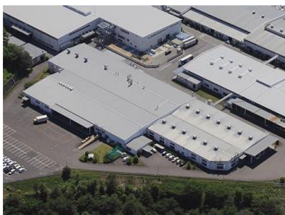
ブリヂストンスポーツ関工場
